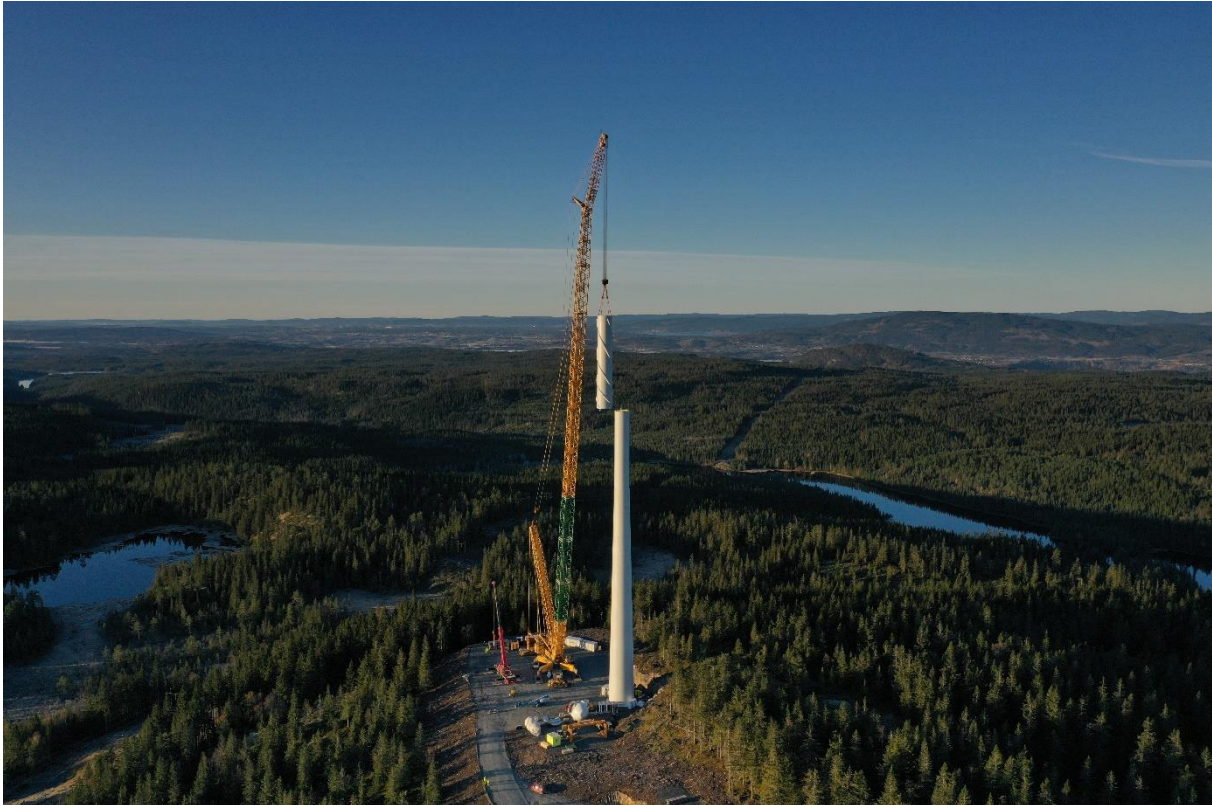
Figur 5. Kranplats och montering av torndelar till vindkraftverk. Foto: Odal Vind
