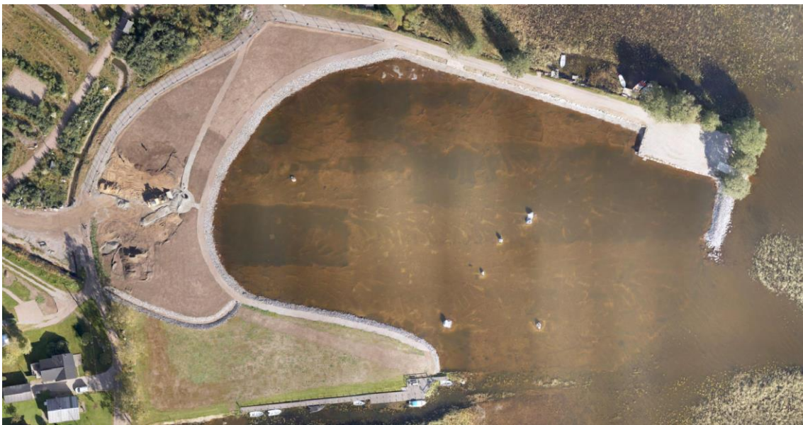
Figur 5.3. Flygfoto från maj 2022 som visar slutet på återställningen av invallningen.
