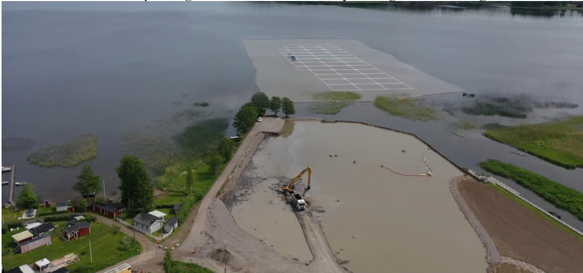
Figur 6.1. Flygfoto från 2022 och saneringsarbeten sker med långarmad grävmaskin vid invallningen och innanför spont och av sediment ute i Tisaren med sugmuddring innanför siltskärm.
