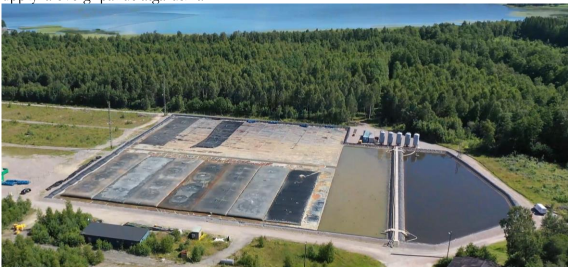
Figur 6.2. Flygfoto från 2022 som visar avvattningsytan med geotuber och tillhörande vattenbassänger och reningsanläggningar.
