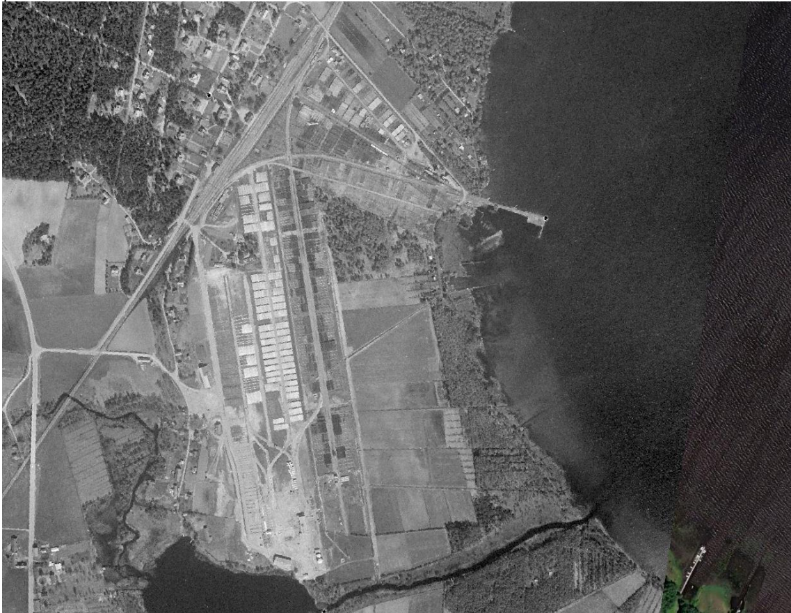
Figur 2.1. Flygfoto från 1953 som visar verksamhetens omfattning på Åsbro gamla och nya impregneringsplats
