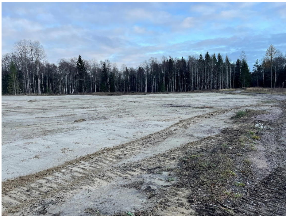
Figur 6c: Fotografi taget åt ost - nordost över område A och delar av område B vid slutbesiktning. Fotograf står på grusade delen av Brädgårdsvägen som går i öst-västlig riktning skymtas utmed fotografiets vänstra sida. (för hela vägen i östlig ritning se figur 6b).
