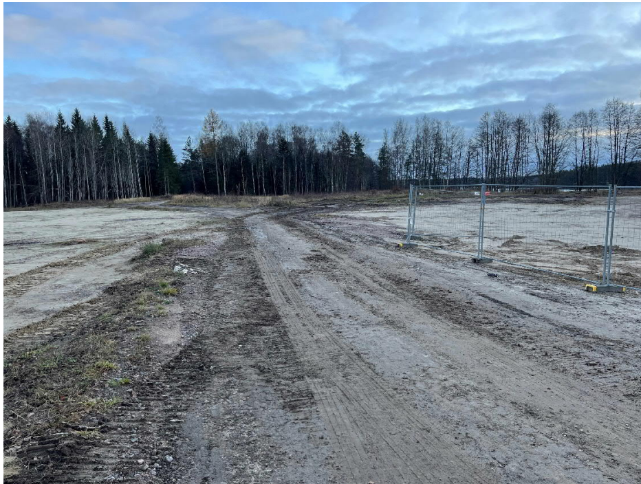
Figur 6b: Fotografi taget åt öst av grusade Brädgårdsvägen (löper i öst-västlig riktning vid slutbesiktning. Till höger i bild (söderut) skymtas område C och till vänster i bild (område A och B, åt norr). Fotograf står på Brädgårdsvägen samma läge som föregående fotografier. Denna del av Brädgårdsvägen, den grusade delen, går ej väst om område B (där ligger den bredare asfalterade delen av Brädgårdsvägen)
