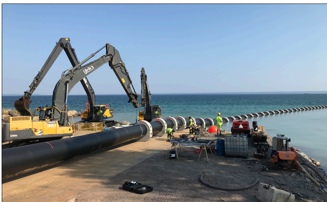
Fig. 5. En ny sjöledning för Skarborgsvattens intag i Vättern anlades år 2019. Kommunalförbundet Skarborgsvatten förser cirka 100 000 invånare med dricksvatten.
