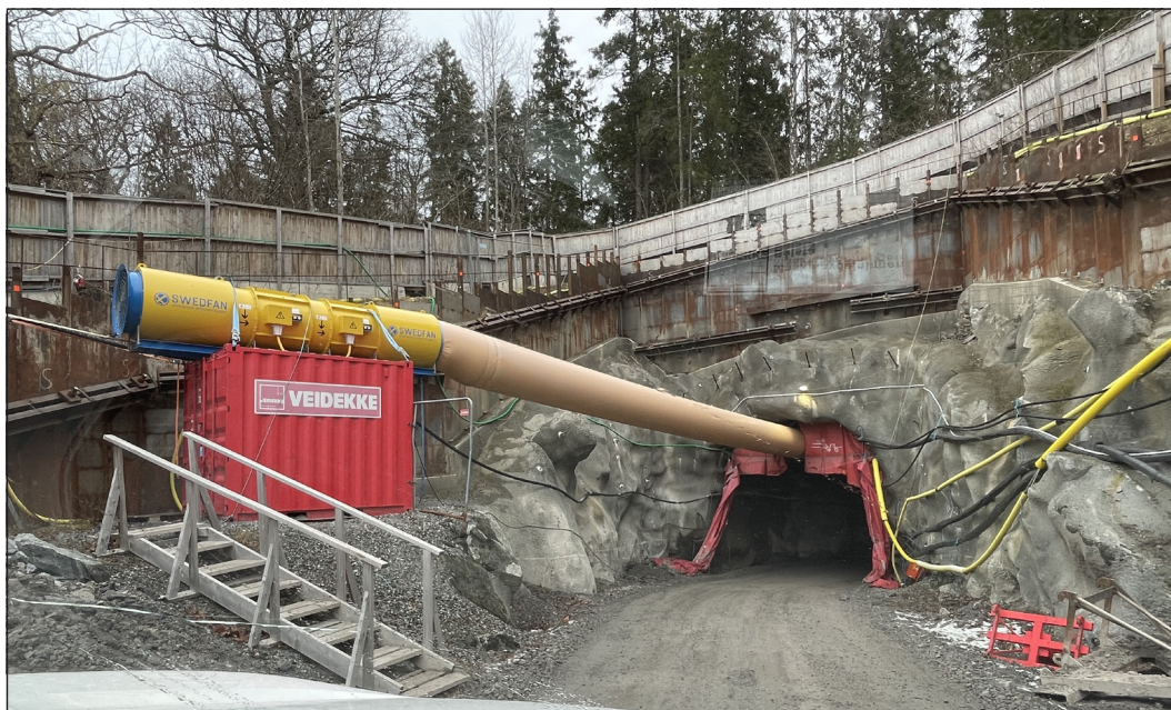
Fig. 30. Exempel på påslag för arbetstunnel. På röd container ses fläkt för friskluftventilation. Från byggnation av avloppstunnel i Bromma. Foto: Albin Månsson.
