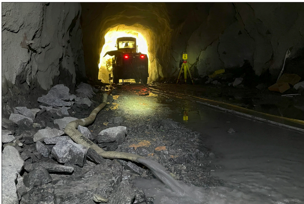
Fig. 32. Salvborrning i Zinkgruvan. Vattenförbrukningen kan uppgå till cirka 150 liter per minut per bormaskin under pågående borrning. Processvatten som används pumpas bort (länshålls) från tunnelfront och avrinner i tunneln till pumpgropar. Foto: Albin Månsson.
