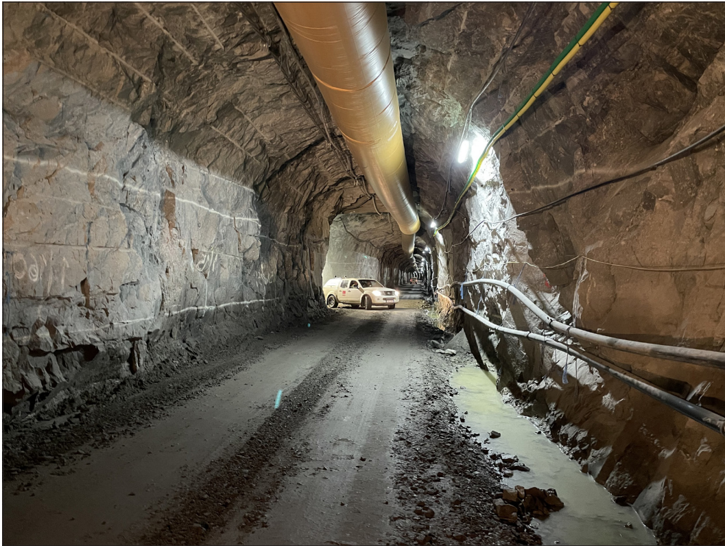
Fig. 25. Bergtunnel med cirka 25 m 2 teoretisk area. Berget uppvisar hög bergkvalitetsklass med begränsat behov av bergförstärkningsåtgärder. Ovanför diket till höger i bild hänger bl.a. processvattenledningnar och kraftkablar. Från byggnation av avloppstunnel i Bromma. Foto: Albin Månsson.
