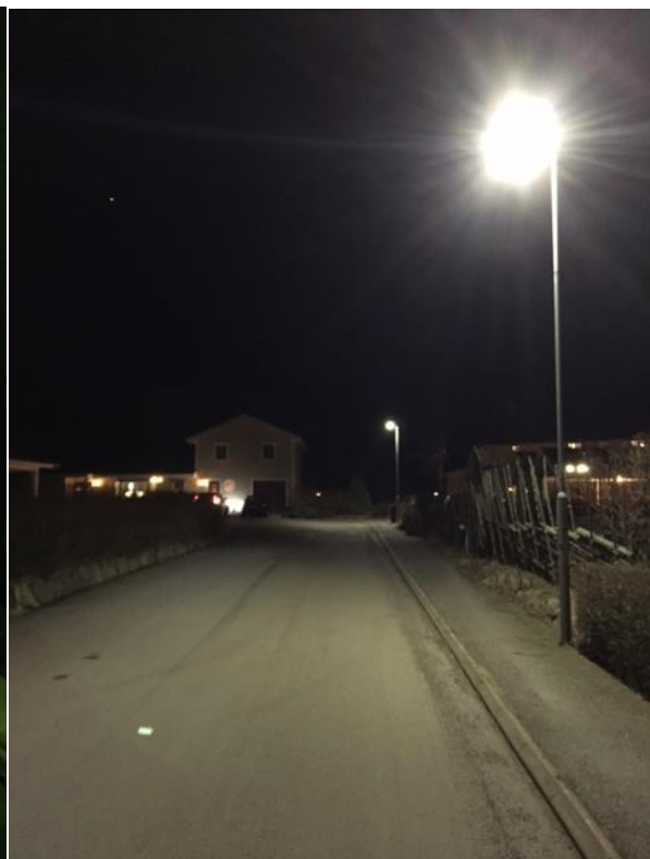
utbytt med stolpförlängare och LED35 w
