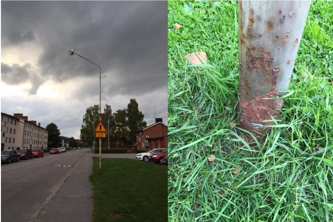
Äldre stolpe . De mest akuta 100 st stolparna är i liknande skick som den på bilden.
